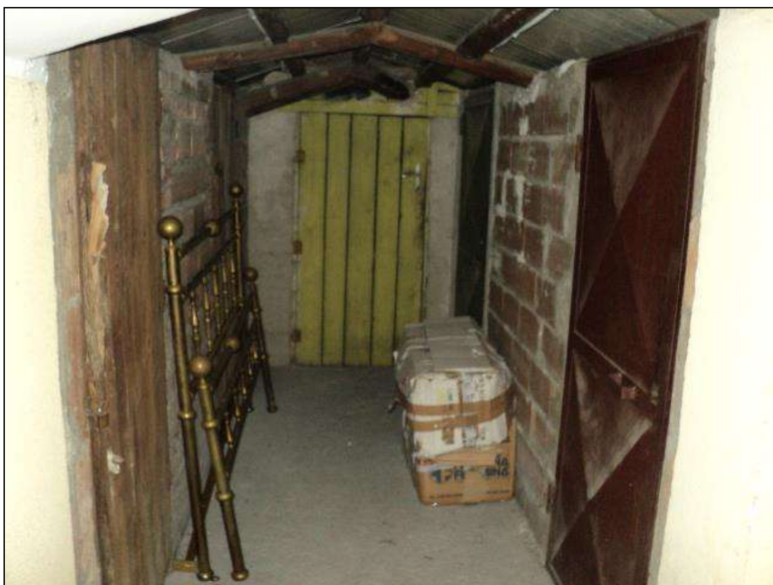
Foto N. 12: Ingresso al locale soffitta.
