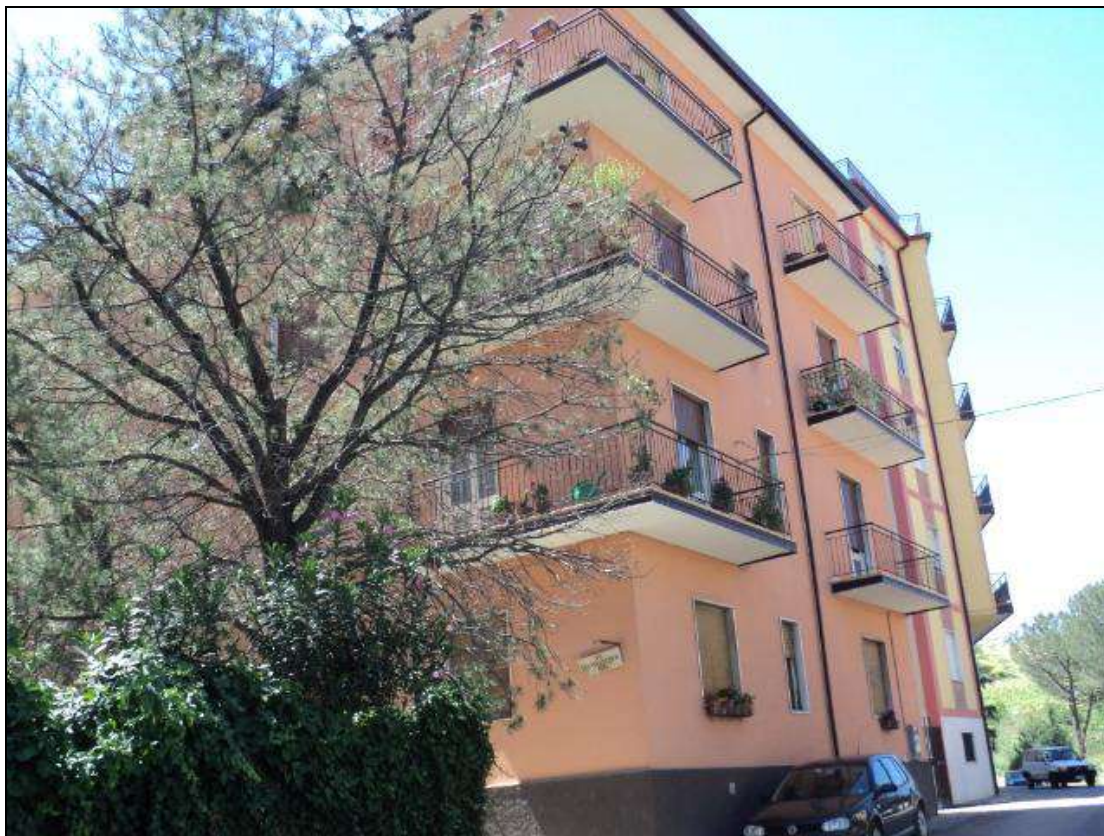
Foto N. 1: Fabbricato in cui è sito l'immobile oggetto di stima.
